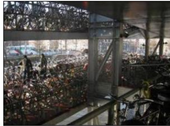
Ilustración 54 Aparcamiento colectivo de bicicletas en la Estación Central de Ámsterdam, Países Bajos. Fuente: Manual de aparcamientos de bicicletas del IDAE.
