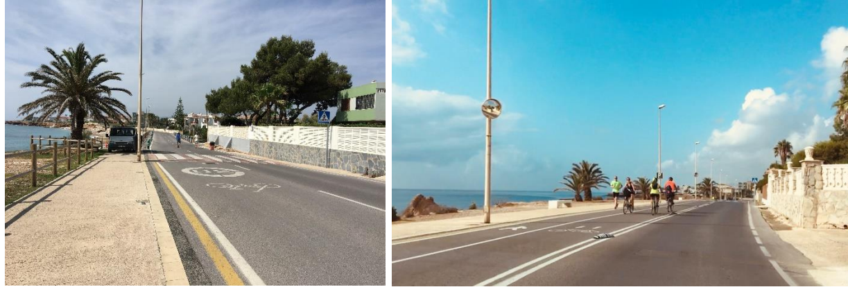
Ilustración 203. Recuperación de accesibilidad transitoria previa a la reurbanización del vial. Izquierda antes doble sentido, derecha sentido único y reserva modos activos.
