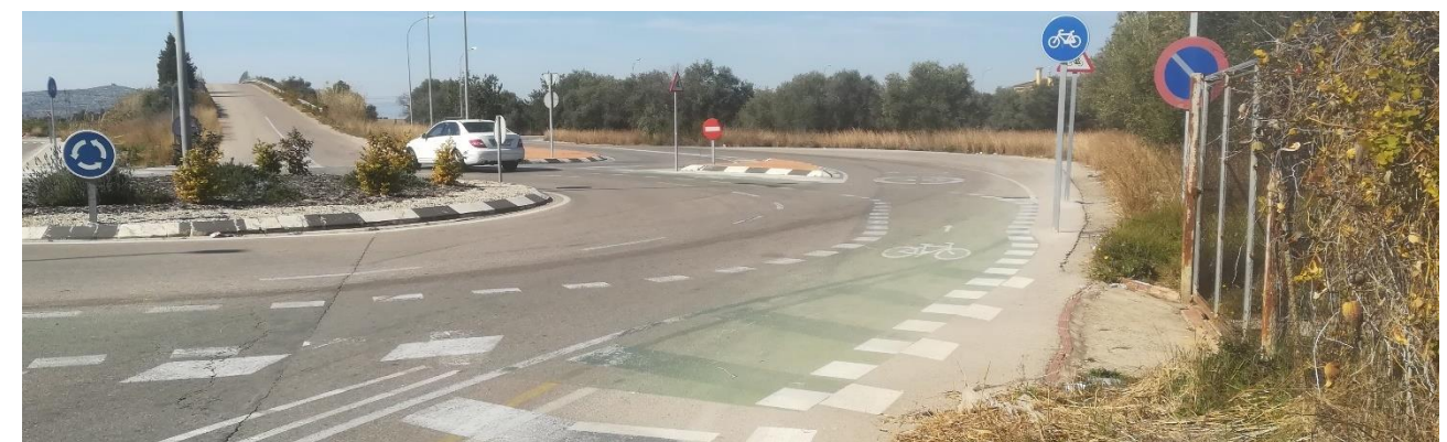
Ilustración 218. Av. Gil de Atroncillo. Acceso desde C. dels Dauradors. Señalización vertical de inicio de itinerario ciclista, limitación de velocidad de circulación a 30km/h y señalización horizontal de ciclocalle. Fuente: Elaboración propia
