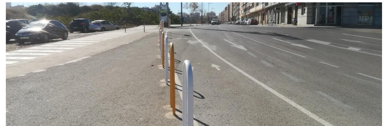
Ilustración 213. Carril bici en C. Leopoldo Querol. Necesidad de segregación física adecuada de los diferentes modos de transporte para mejorar la seguridad del ciclista. Fuente: Elaboración propia
